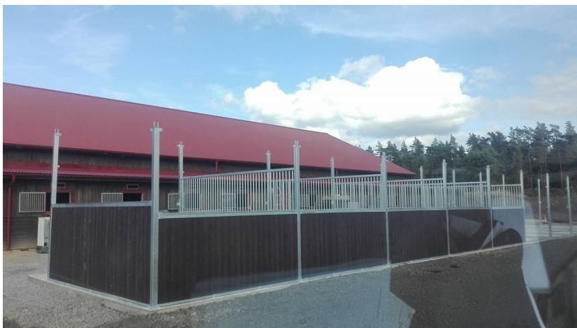
Plank nedtill, h-profiler och galler är på plats.
