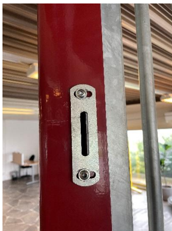
Låsbricka, en mindre till överdelen och en större till nederdelen.
