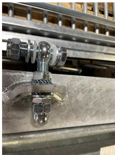
Gångjärn monterat på dörr.
