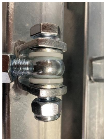
Gångjärn monterat i gångjärnsfäste.
